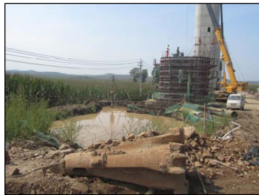
施工现场沉淀池照片
