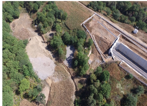
足民隧道出口弃渣场
