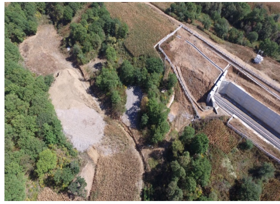
足民隧道出口弃渣场
