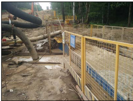
泥浆池现场照片
